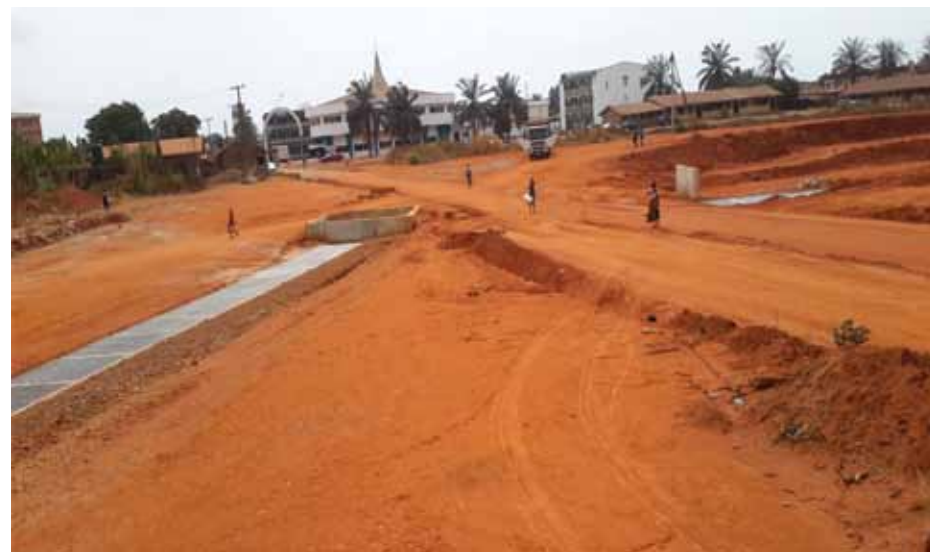
Zone d'intervention du projet SAWAP, Queen Edge, Nigéria
