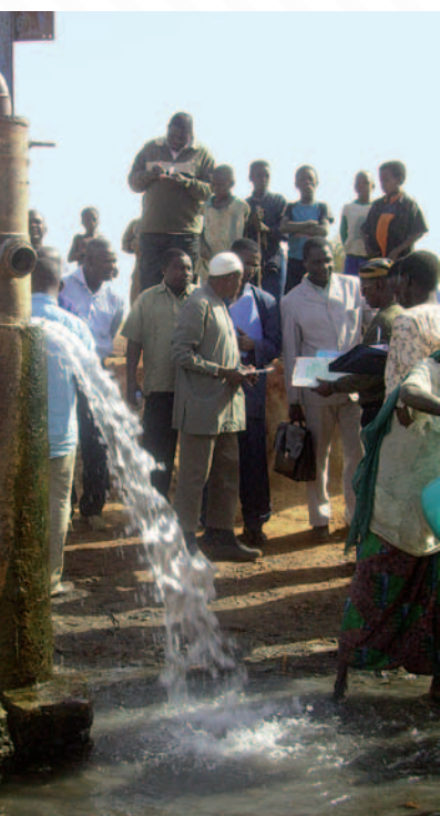
Forage artésien à Banouzoumbou – Niger, 2007
